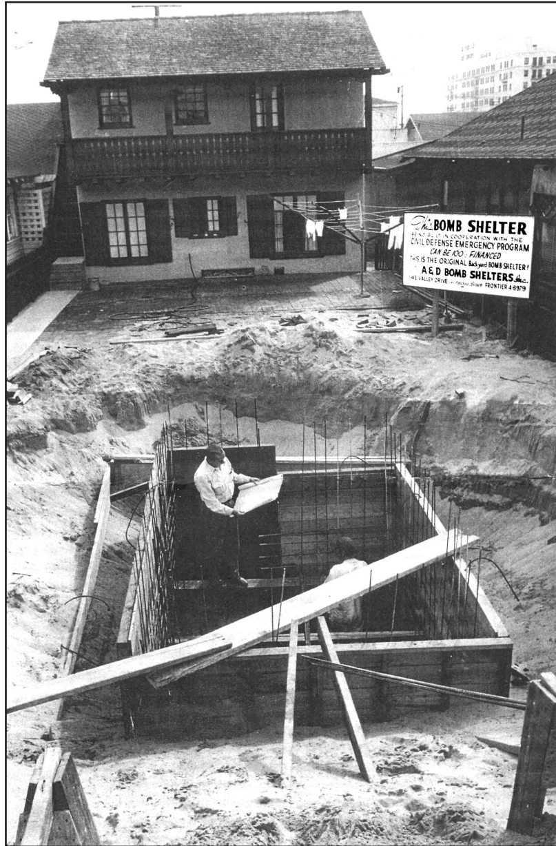
Construcción de un refugio antiaéreo
