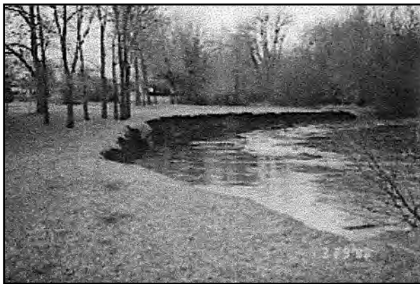
Antes de una tormenta de lluvia intensa
